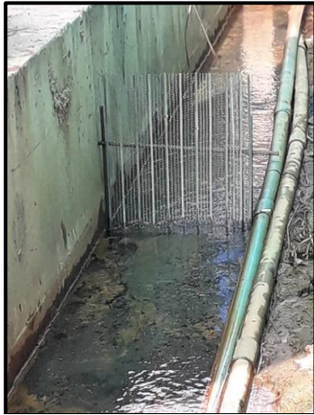
รูปที่ 43 ตะแกรงคัดขยะก่อนระบายน้ำออกจากโครงการ
