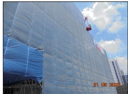
รูปที่ 8 ติดตาข่ายกันฝุ่น (Mesh sheet) คลุมโดยรอบอาคาร
