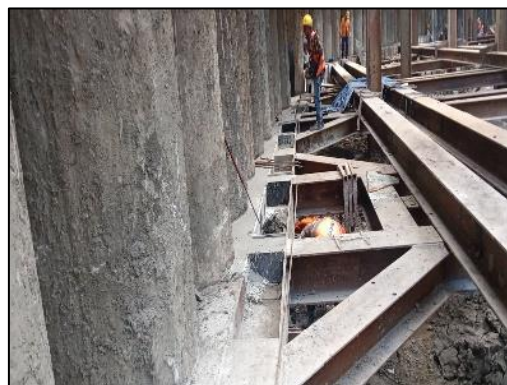
รูปที่ 30 ผนังกันดิน (Diaphragm Wall)
