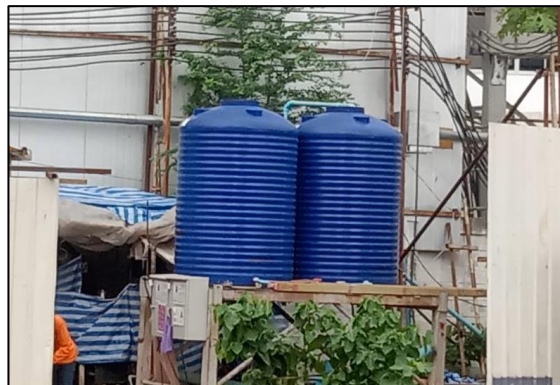
รูปที่ 90 ถังน้ำสำรองสำหรับใช้สเปรย์น้ำ เพื่อลดฝุ่น
